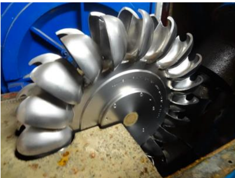
Blick auf die Pelton-Turbine bei der techn. Überprüfung der Anlage
