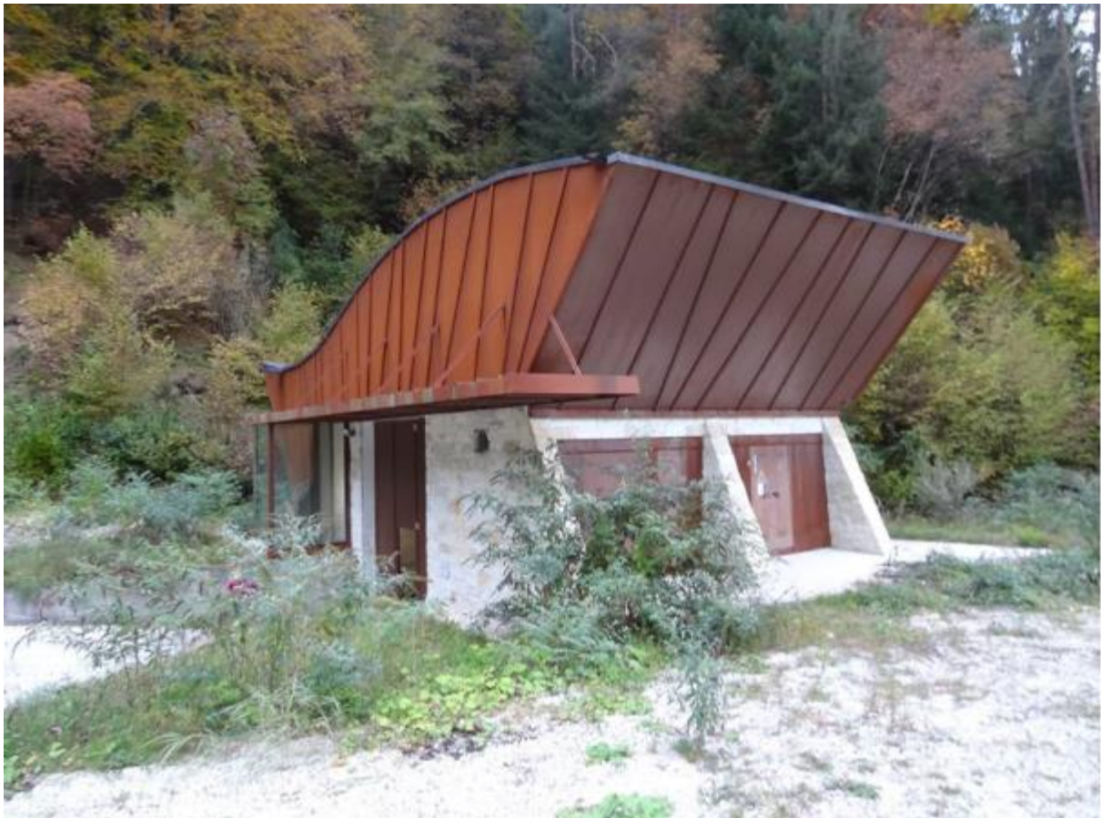
Powerhouse des Kraftwerkes Vallesina
