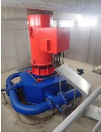
Pelton Turbine des Wasserkraftwerkes Korpitsch
