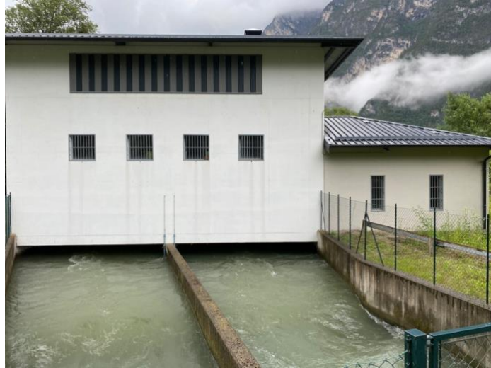
Powerhouse WKW Ospedaletto/Brenta
