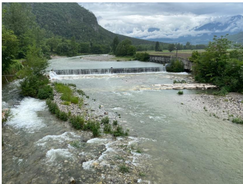
Der Fluss Brenta am Einlauf zum Kraftwerk
