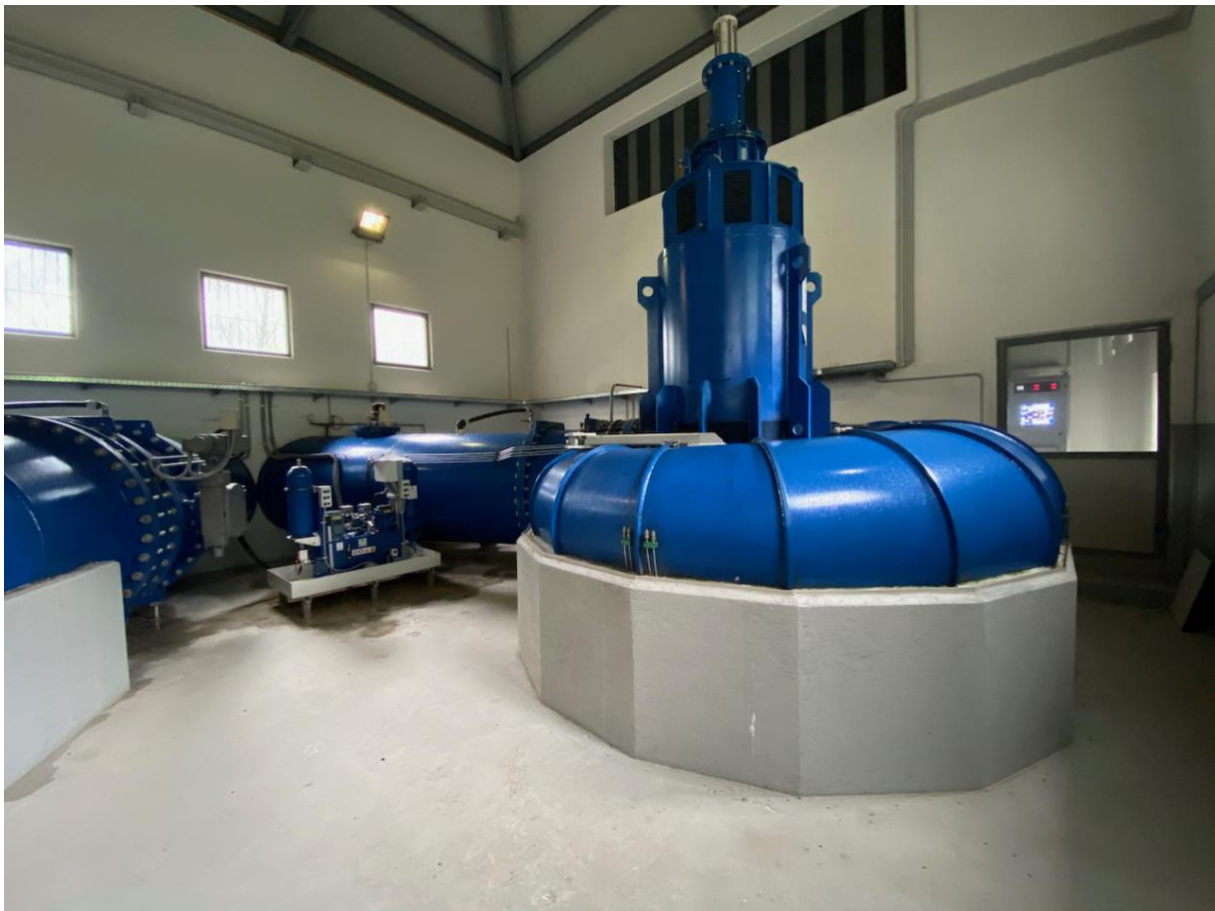
Kaplanturbine des WKW Ospedaletto/Brenta
